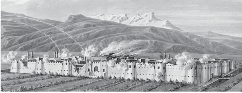
Şəkil 1. Sərdarabad qalası
